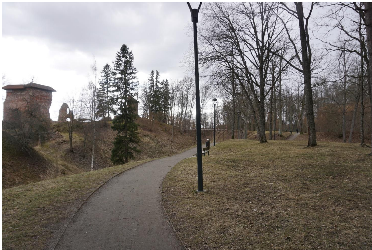
Foto 104. Tee äärtesse paigutatud metallist piirded on liiga kõrgel võrreldes tee enda kõrgusega. Metallist ääred võivad olla parkis liiklejatele ohtlikud. Teekatend tuleb uuendada (graniitsõelmete ja paekivituha seguga) ja tee ääred korrastada. 2021. Foto autor: Laura Andla. 177
