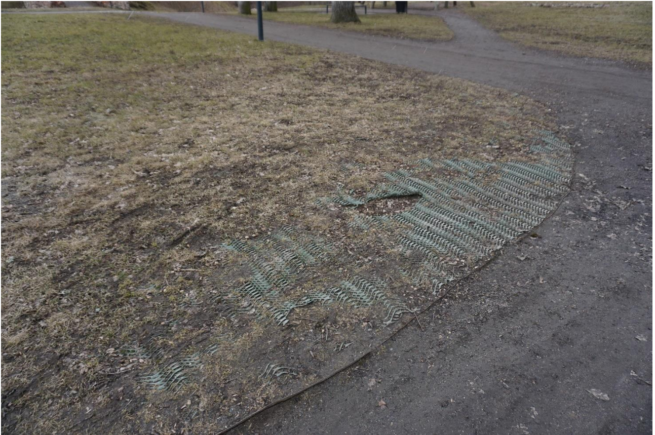
Foto 102. Lagunemas, osaliselt ohtlik muru- ja teeala piire ja aluskate (metallvõrk). Ala vajab täiendava murukaitse paigaldamist ja ohtlike elementide likvideerimist/parandamist. 2021. Foto autor: Laura Andla. 175
