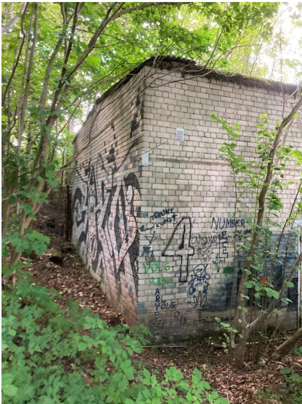
Foto 66. Hoone Lossipargi lääne piiril. 2021. Foto autor: Kreet Sipelgas. 138
