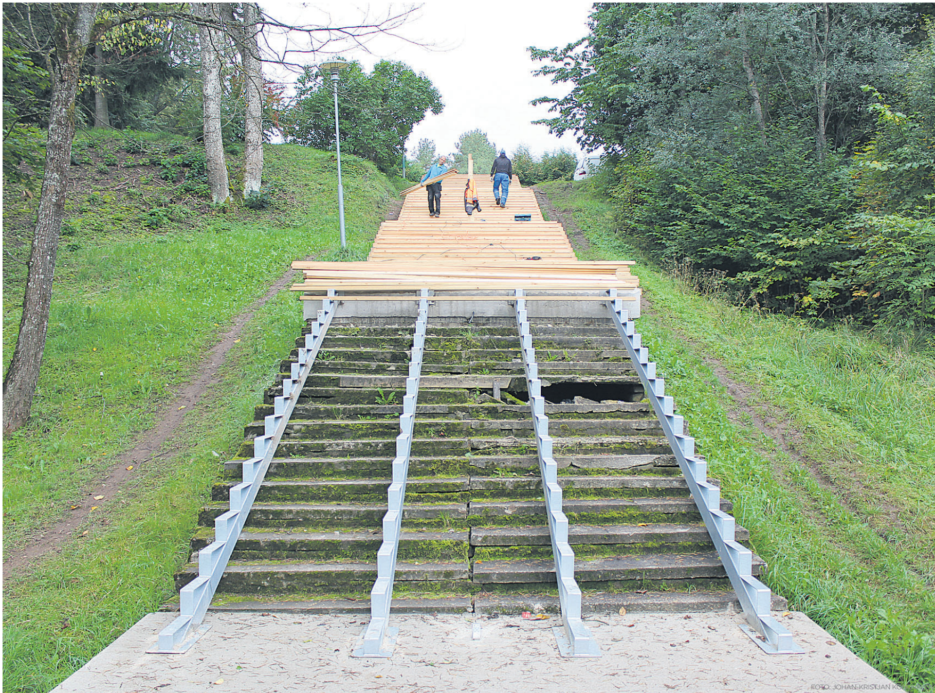
Möödunud reedeks olid AS-i Pärlni töömehed jõudnud trepiastmete paigaldamisega poole peale. Septembri lõpuks on vana trepi sees haigutavad augud kaetud Siberi lehisest valmistatud laudadega, mis toetuvad uutele konstruktsioonidele.
